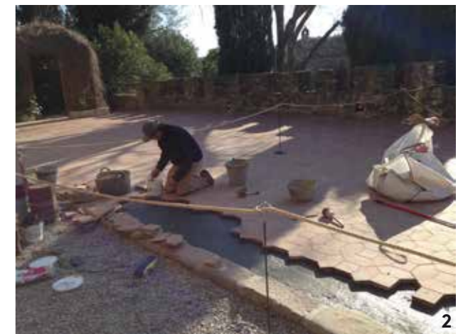
1. Neteja dels ous que coronen la Torre Galatea 2. Tasques de paleta a la terrassa del Delme, a Púbol 1. Limpieza de los huevos que coronan la Torre Galatea 2. Labores de albañilería en la terraza del Diezmo, en Púbol
